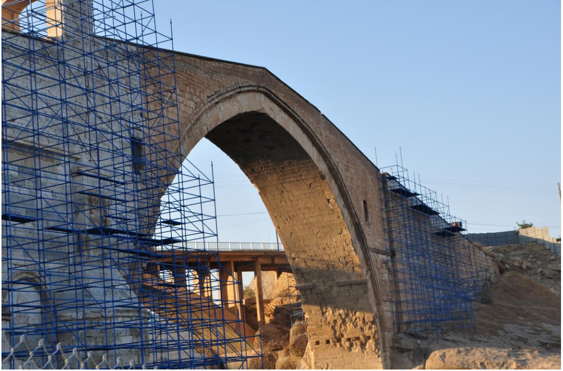
Resim 77: Malabadi (Batman Suyu) Köprüsü
